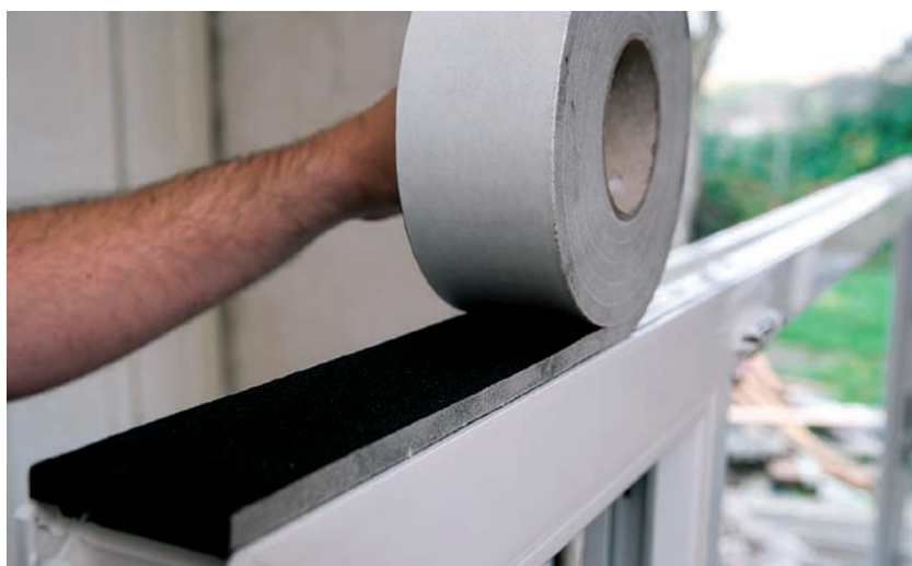
Obr. 4: Páska illmod Trio řeší třívrstvé utěsnění spáry jedním produktem podle pravidla „uvnitř těsněji než venku“. Je vhodná zejména do nových otvorů s pravidelnou spárou, dobře se uplatní např. u dřevostaveb
